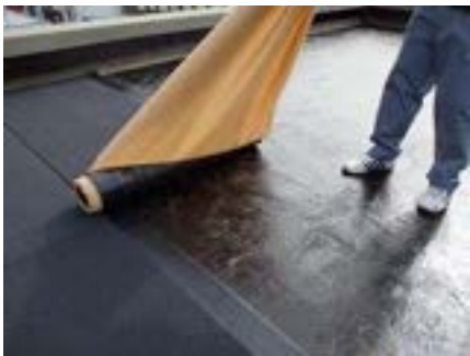
敷き込み作業状況
