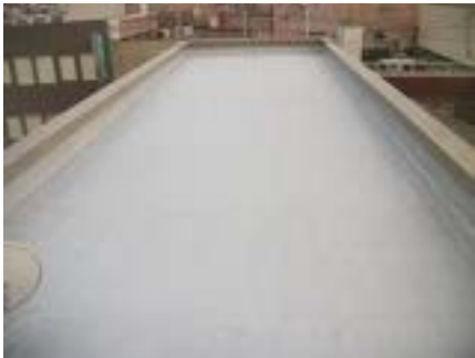
施工完了状況
