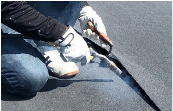
シートジョイント部 トーチ融着接合状況
