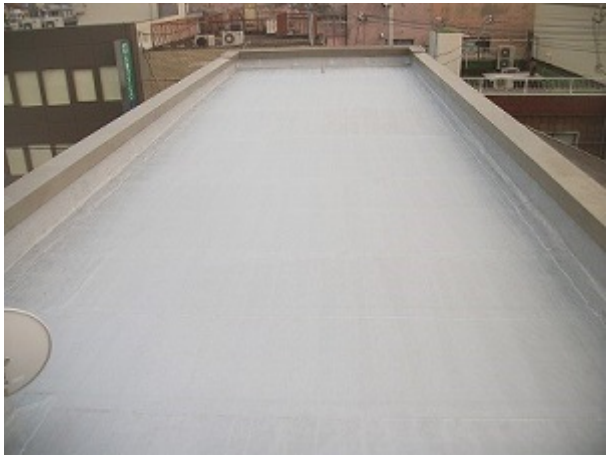
施工完了状況
