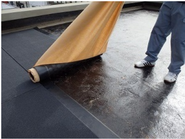
敷き込み作業状況
